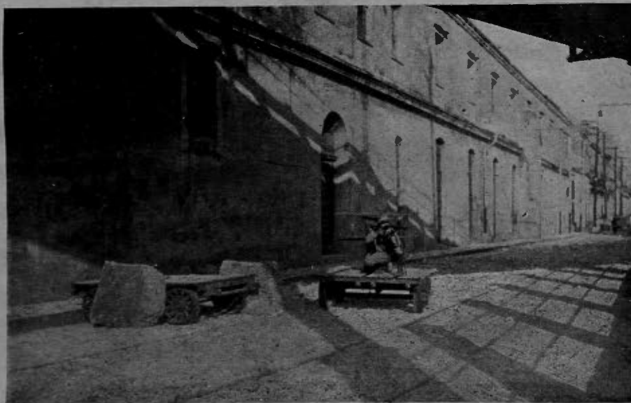
El antiguo Cuartel de San Ambrosio era uno de los edificios públicos que iba a ser pasto de las llamas.—(Fotos de VALES)
